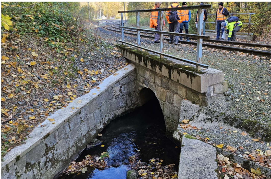
Obrázek 1. Pohled na vtokové čelo propustku
