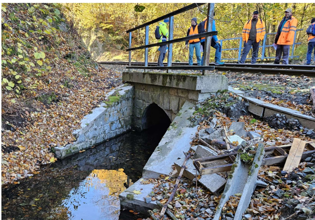
Obrázek 2. Pohled na výtokové čelo propustku, nutná obnova odláždění za křídlem
